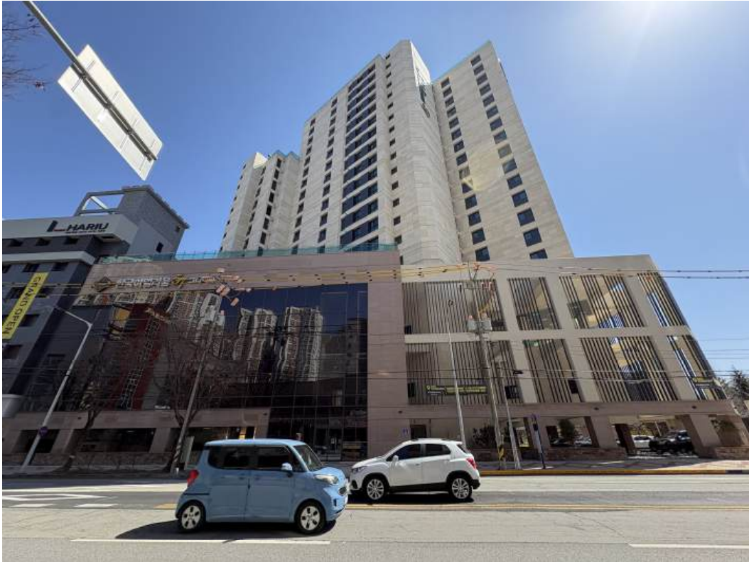
【 전체 건물 전경 】
